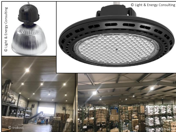
HQL-Pendelleuchte (o.l.), 150 W-LED-Pendelleuchte (o.r.), Entkeimung (u.l.) und Rohwarenlager mit neuer Beleuchtung bei der trokost in Steigra
