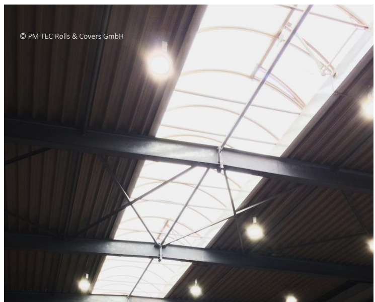
LED-Beleuchtung mit tageslichtabhängiger Steuerung bei PM TEC.
