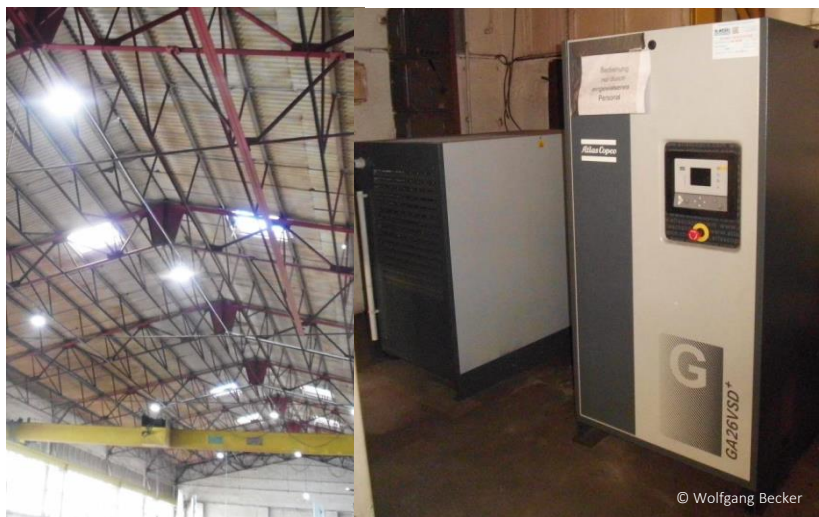
LED-Hallenbeleuchtung und drehzahlgeregelte Druckluftanlage (rechts).
