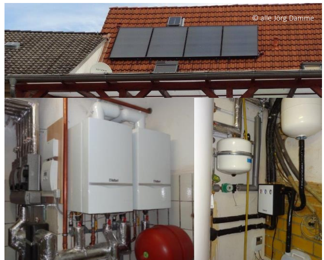
Solarpaneele (oben), Brennwert-Thermen (u. l.) und isolierte Heizkreisläufe.
