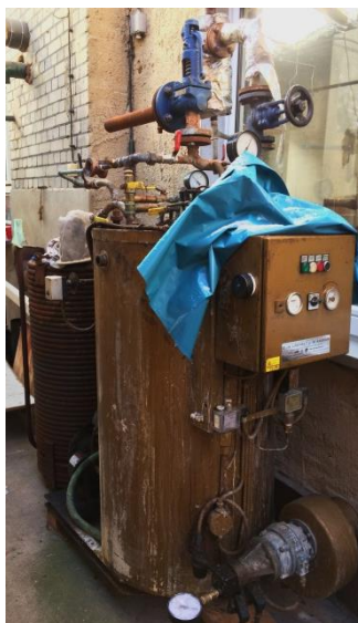
Heizöl betriebener Dampferzeuger aus dem Jahr 1992 (links) und Effizienzgerät Baujahr 2016
