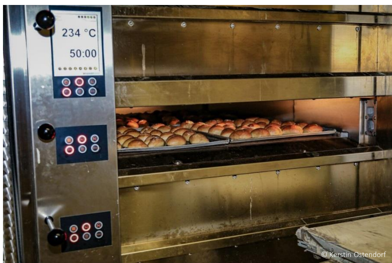
neuer Etagenbackofen in der Bäckerei Möhring
