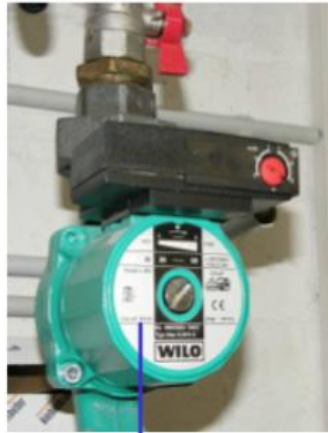
Regelpumpe, ältere Bauart (ohne Display, hier 36-99 W)
