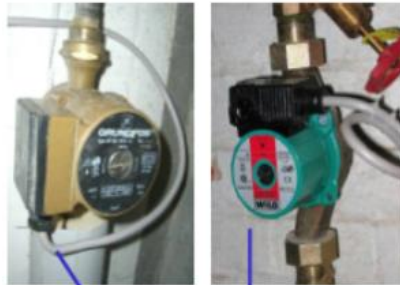
einstufige Heizungspumpe (hier: 75 W)
