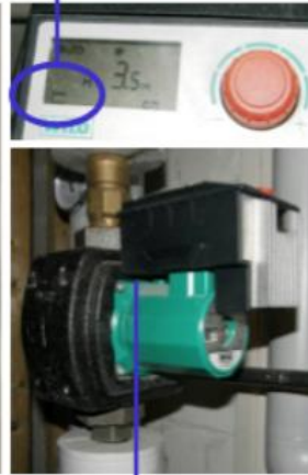
Regelpumpe, neuere Bauart (mit Display, hier 30-200 W)
