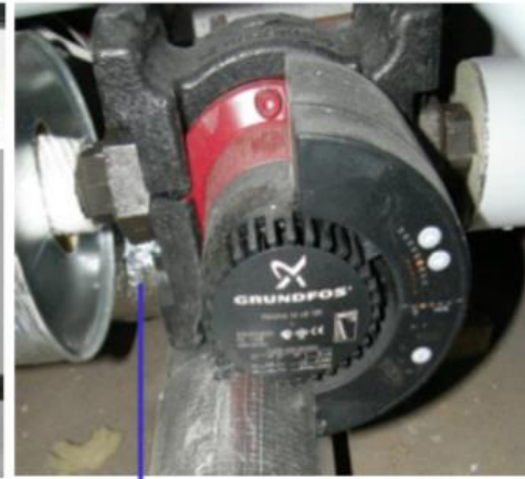
Hocheffizienzregelpumpe, neueste Bauart (per Funk fernprogrammierbar und auslesbar, hier 10-85 W)
