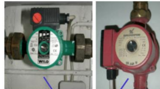
mehrstufige Pumpen (hier: 46/67/93 W bzw. 30/45/60W)
