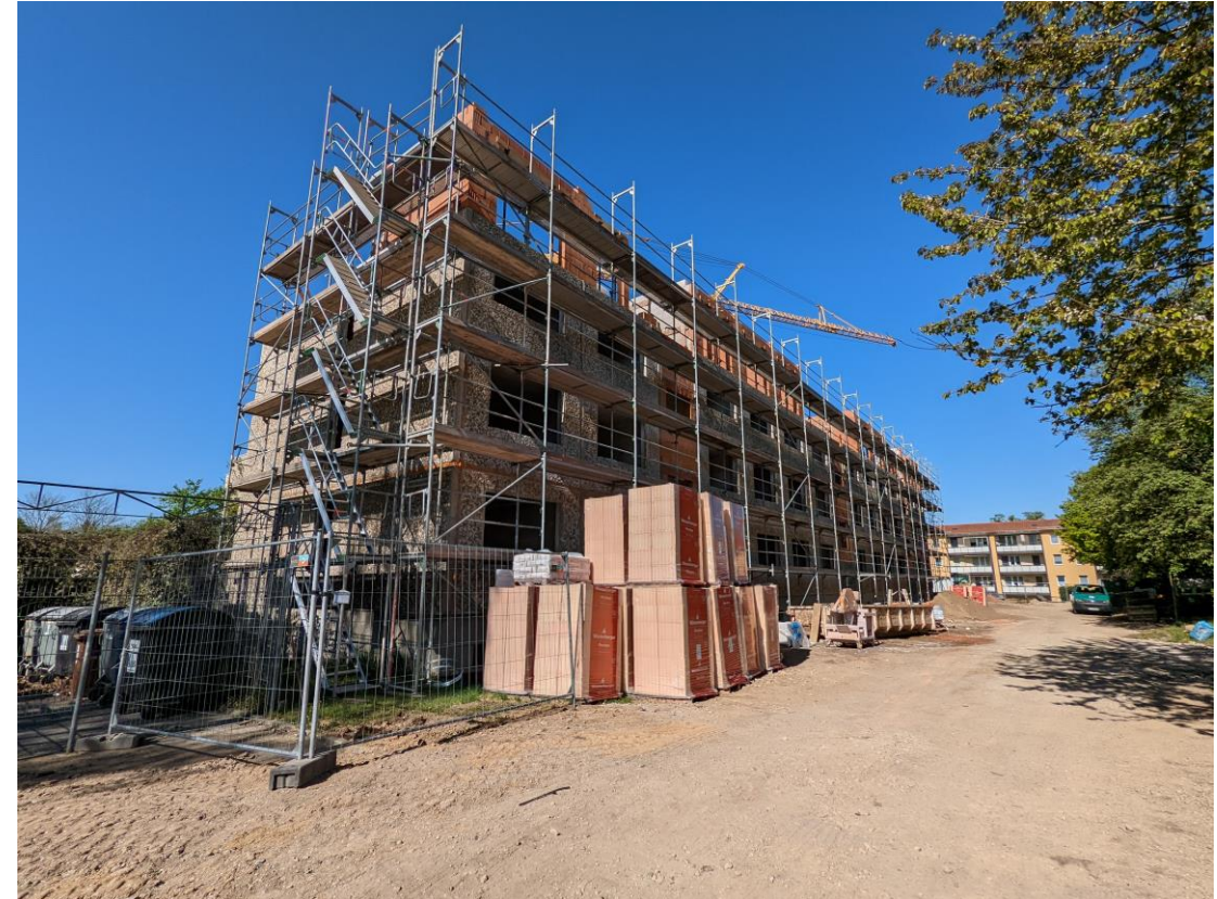
während der Bauphase
