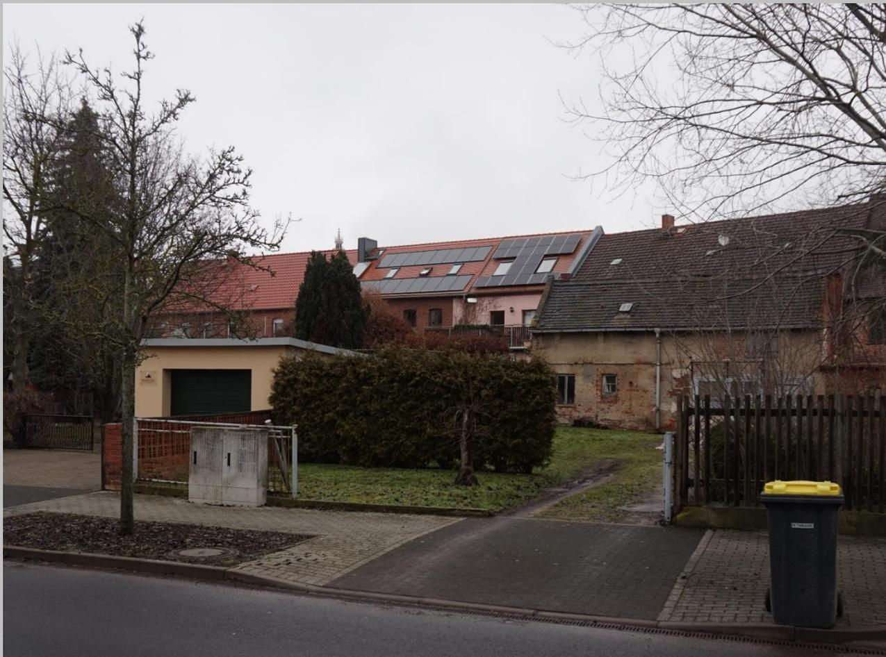
Indach Solarthermie links, Aufdach PV rechts; abermals Kontrast zwischen Dach- und Modulfarbe
