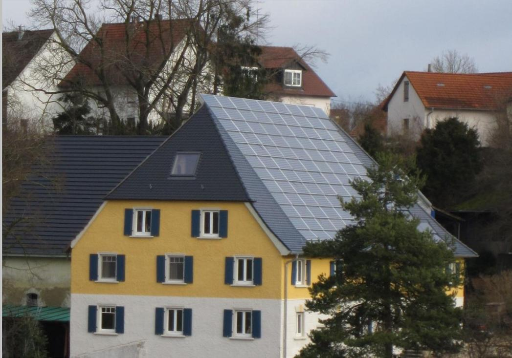
neue „harte Kanten“ durch eine über den First hinausgezogene Anlage (links, rechts oben) bzw.
