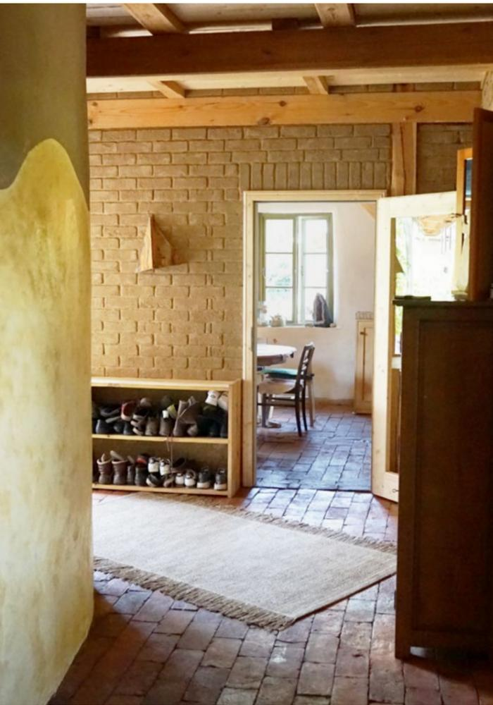
oben: Die Lehmsteine und die mit Lehm verputzten Innenwände korrespondieren hervorragend miteinander und sorgen in allen Zimmern für eine behagliche Atmosphäre.
