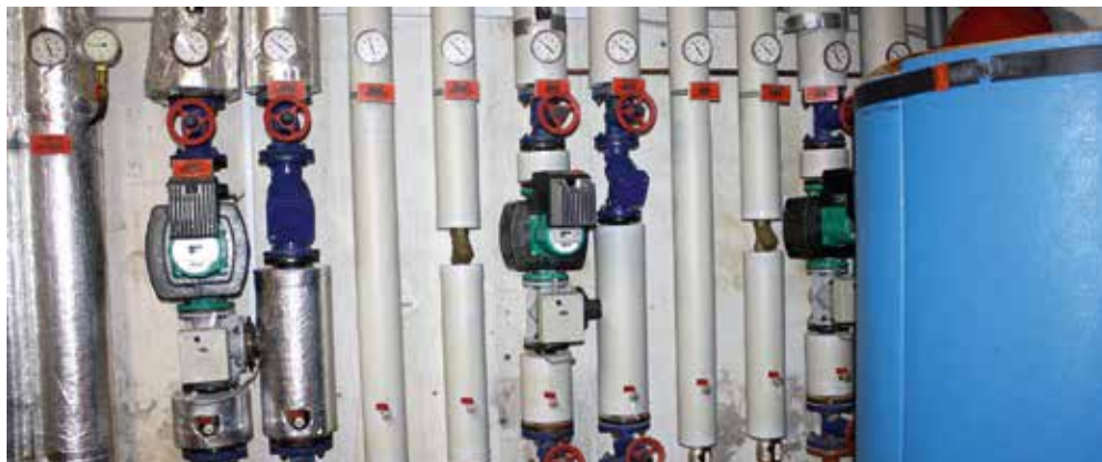
Foto: gedämmte Heizungsrohre, Florian Kliche
