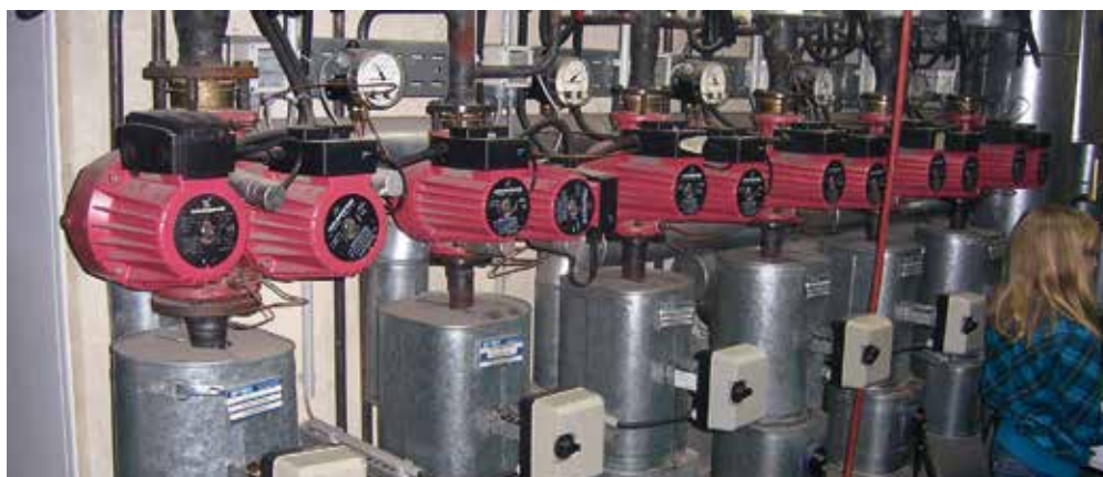
Foto: Heizungspumpen an der Verteilstation einer Schulheizung, Florian Kliche
