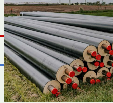
Netz mit Stahlrohren
