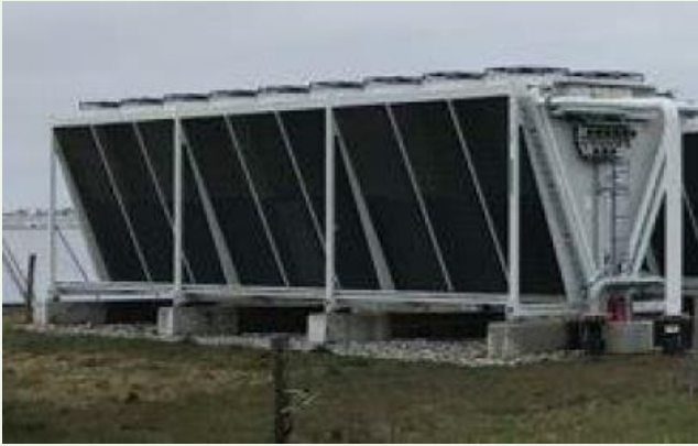
Industrie Luft-Wasser-Wärmepumpe
