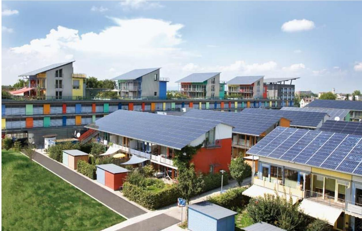
Nutzung der PV-Anlage als Komplett-Dach
