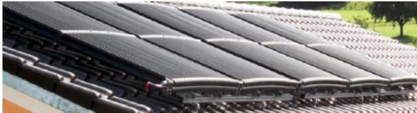
**Umweltenergie** aus Lufttemperatur und Solareinstrahlung werden durch den Solar-Luft Absorber der Wärmepumpe und dem Eisspeicher zur Verfügung gestellt
