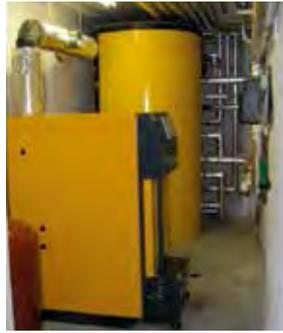
Abb. 12-8 Pelletkessel Heizung
