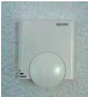
Abb. 8-24 Einzelraum-Heizungsregler
